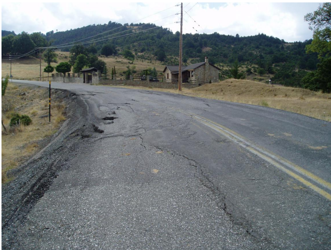
Φωτογραφία 12: Εργασίες πλήρους αποκατάστασης της οδού (εκσκαφές, εξυγίανση, επίχωση, οδοστρωσία, ασφαλική στρώση κυκλοφορίας, διαγράμμιση).
