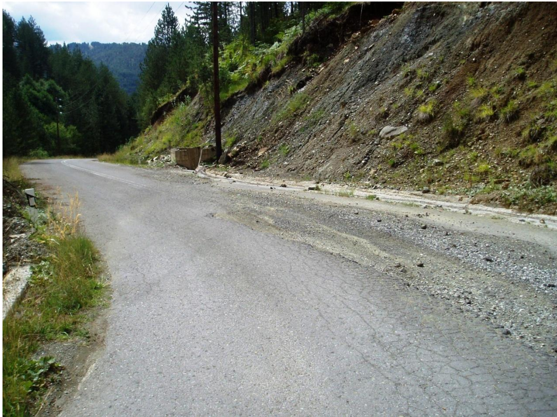
Φωτογραφία 2: Καθαρισμός οχετού και αποκατάσταση ασφαλτικού οδοστρώματος.
