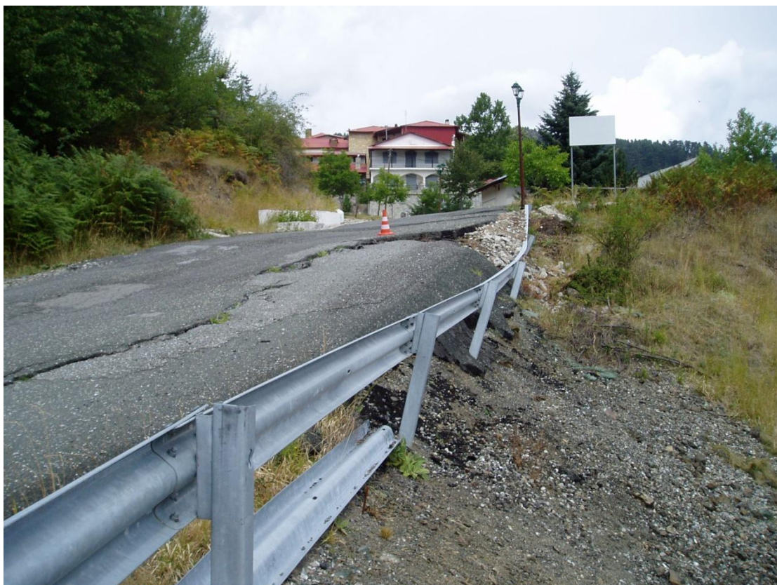
Φωτογραφία 7: Κατασκευή τοίχου αντιστήριξης ύψους 3,00μ. και μήκους 35,00μ. και πλήρης ανακατασκευή της οδού μήκους 110,00μ.
