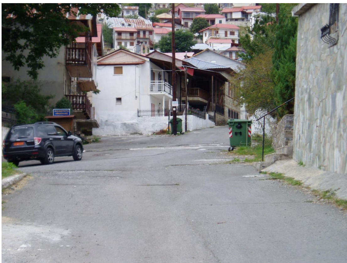
Φωτογραφία 10: Εργασίες ασφαλτόστρωσης εντός του οικισμού (Μέχρι κοινοτικό κατάστημα και μέχρι διασταύρωση μπαρμπέρη).
