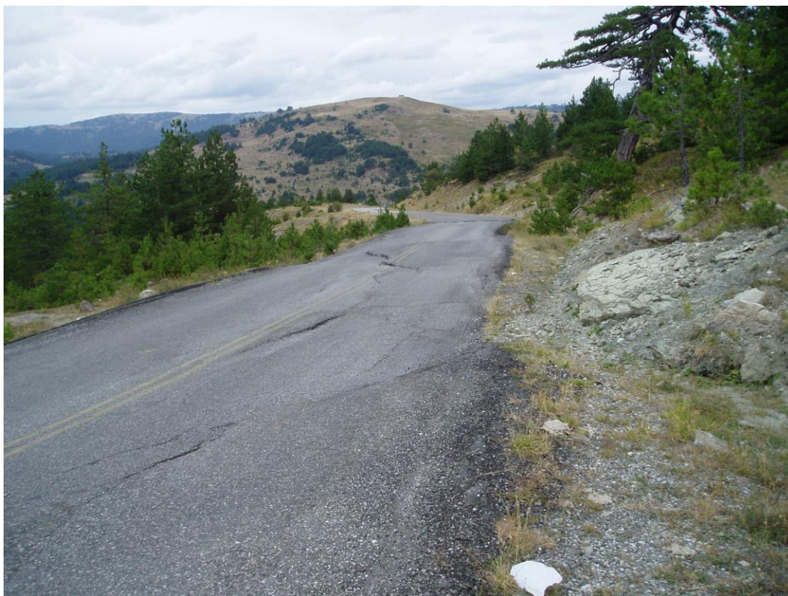
Φωτογραφία 11: Εργασίες πλήρους αποκατάστασης της οδού (εκσκαφές, εξυγίανση, επίχωση, οδοστρωσία, ασφαλική στρώση κυκλοφορίας, διαγράμμιση).
