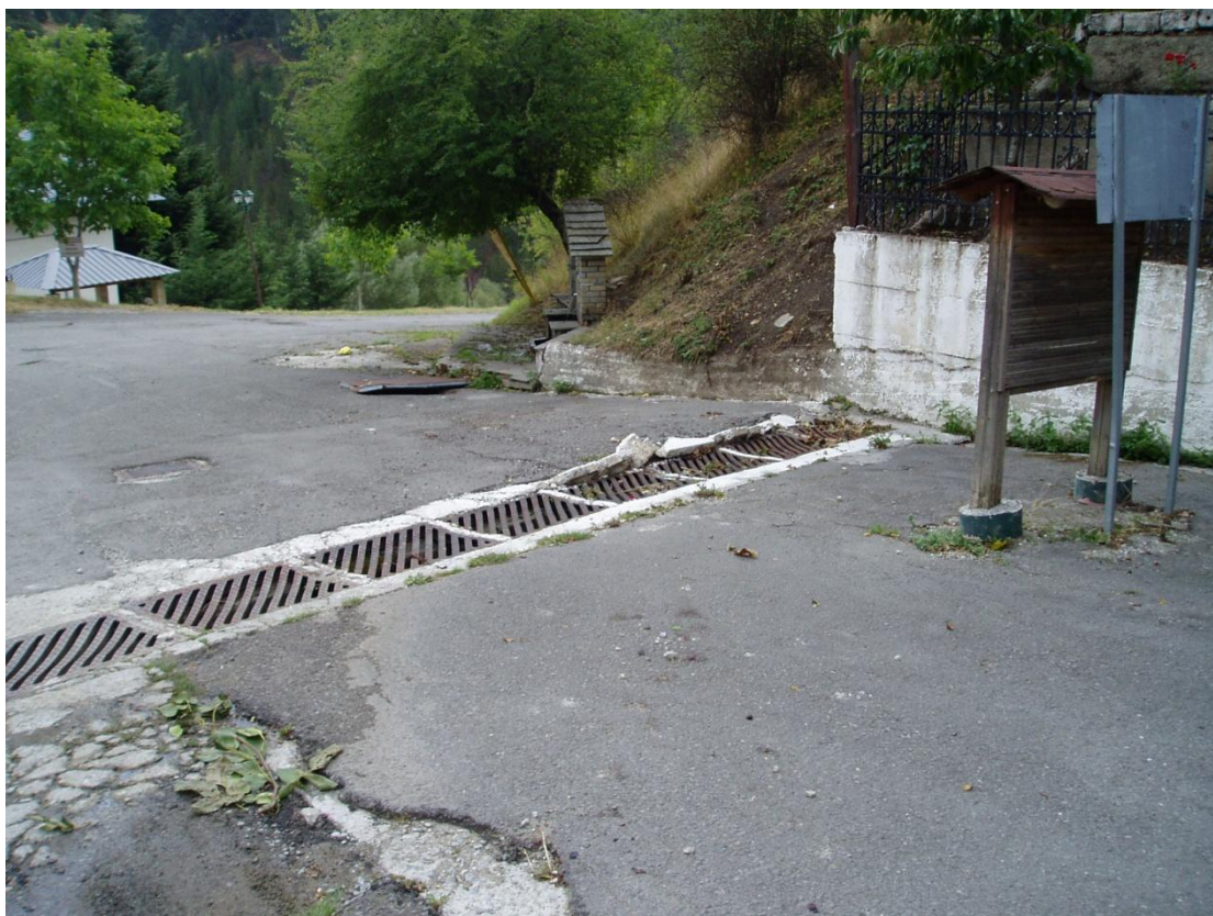
Φωτογραφία 9: Καθαίρεση και πλήρης ανακατασκευή της τάφρου ομβρίων, αποξήλωση και πλήρης ανακατασκευή του ασφαλτικού οδοστρώματος.
