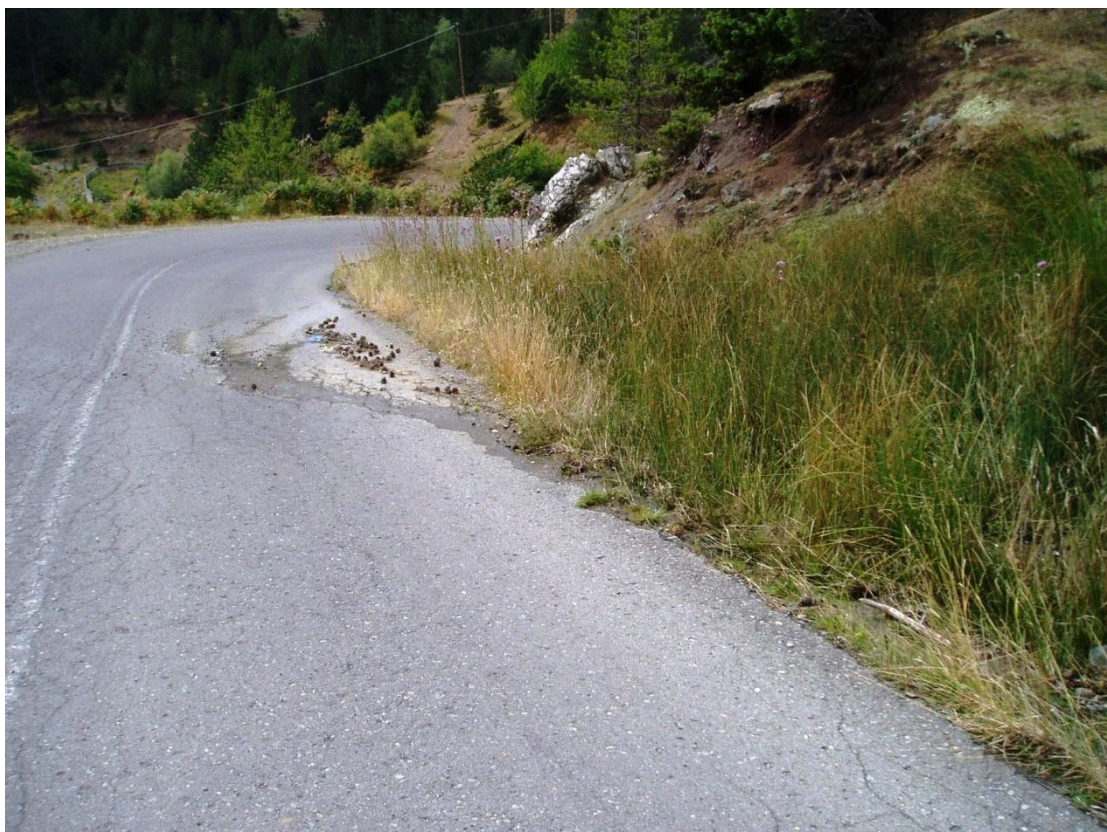
Φωτογραφία 3: Διάνοιξη τάφρου τραπεζοειδούς διατομής μήκους 100 μέτρων μέχρι το υφιστάμενο τεχνικό.
