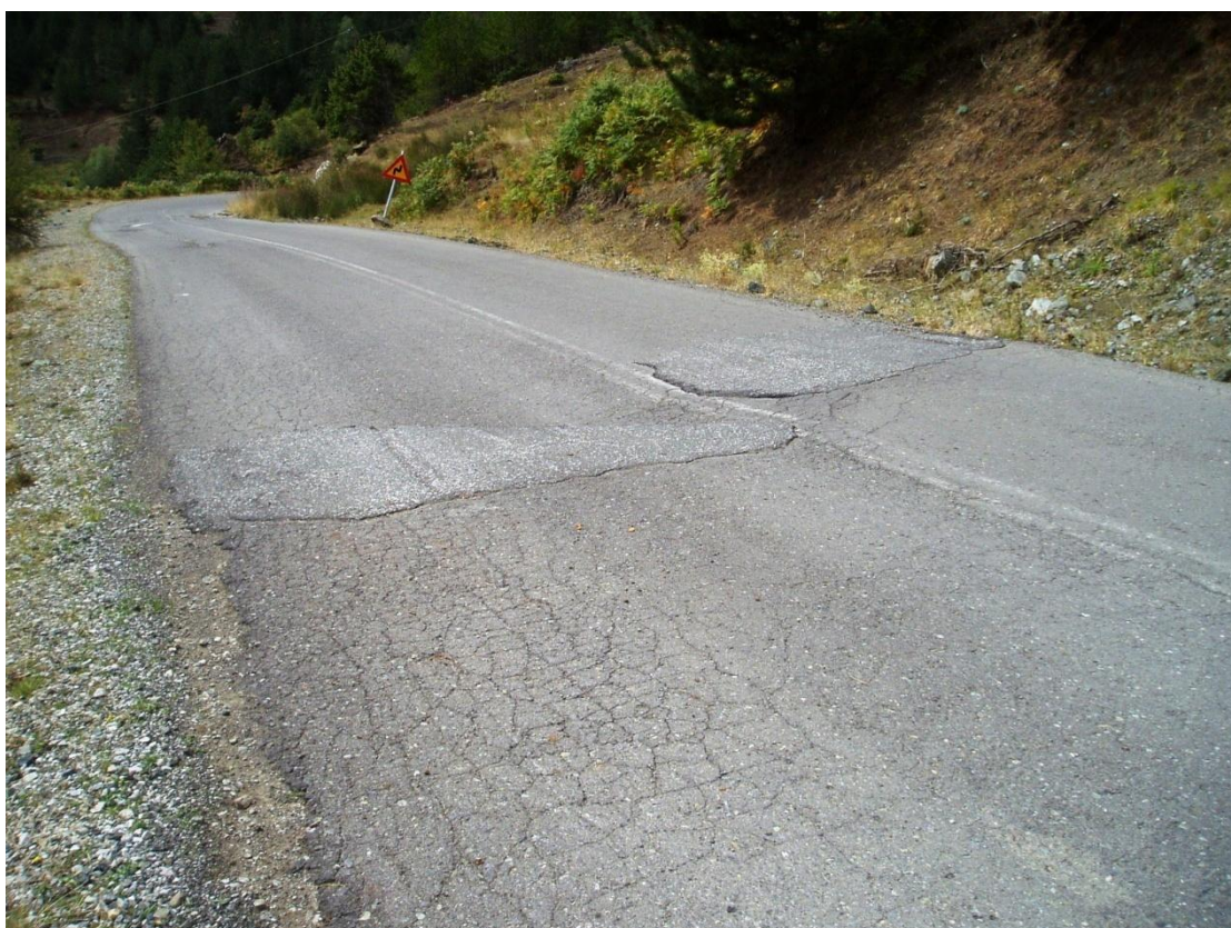
Φωτογραφία 4: Αποκατάσταση καθίζησης οδοστρώματος.
