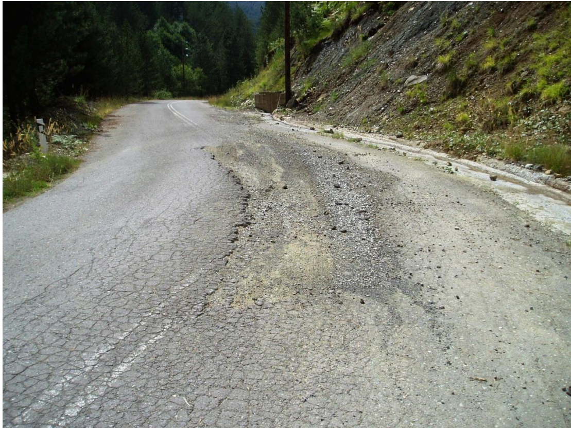
Φωτογραφία 1: Καθαρισμός οχετού και αποκατάσταση ασφαλτικού οδοστρώματος.
