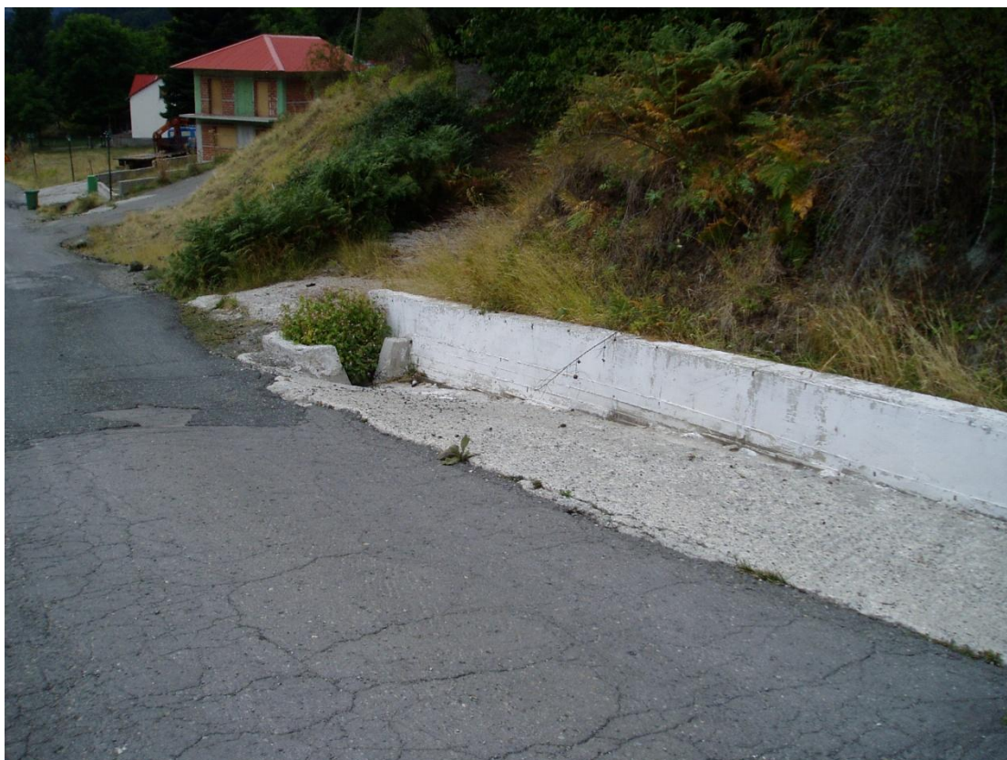
Φωτογραφία 5: Καθαίρεση υφιστάμενου τεχνικού και τοιχίου αντιστήριξης και κατασκευή νέου τοίχου αντιστήριξης ύψους 1,50μ. και μήκους 15,00μ.
