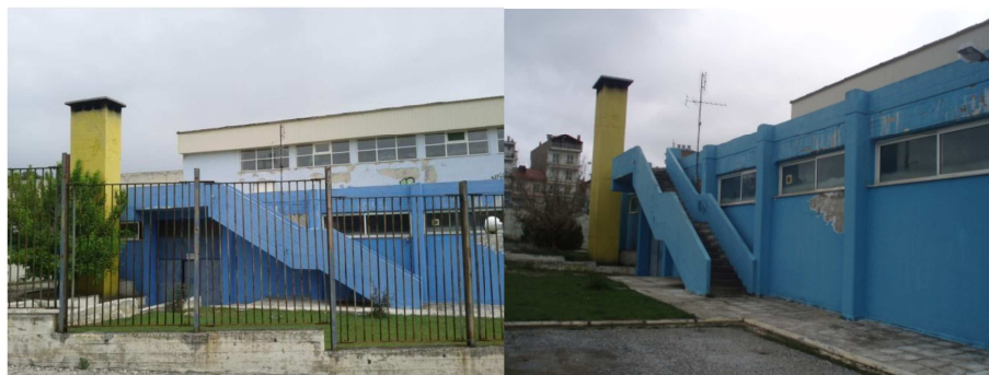
Εικόνα 2: Κτίριο Παρέμβασης (Κλειστό Κολυμβητήριο)
